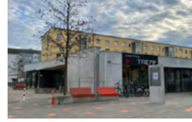
Stadtteiltreff Piusviertel Pfitznerstraße 19a
