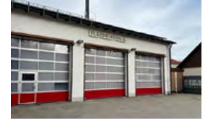
Feuerwehrhaus Unsernherrn Karl-Theodor-Straße 7
