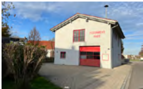
Feuerwehrhaus Pettenhofen Moosweg 9
