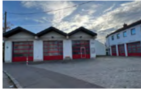
Feuerwehrhaus Etting Faberstraße 9
