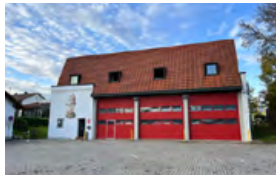
Feuerwehrhaus Mailing Am Seitweg 24
