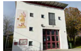
Feuerwehrhaus Hagau Rosenschwaigstraße 105
