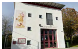
Feuerwehrhaus Hagau Rosenschwaigstraße 105
