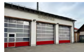
Feuerwehrhaus Unsernherrn Karl-Theodor-Straße 7
