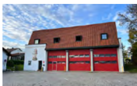
Feuerwehrhaus Mailing Am Seitweg 24
