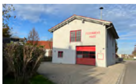
Feuerwehrhaus Pettenhofen Moosweg 9
