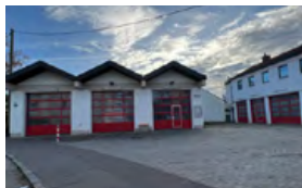
Feuerwehrhaus Etting Faberstraße 9
