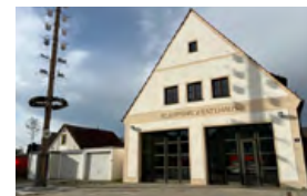
Feuerwehrhaus Zuchering Am Kühlhaus 4
