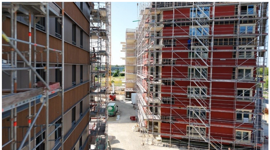
Baustelle an der Hans-Struck-Straße
