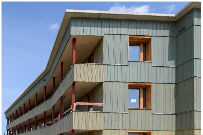
Neubau Steigerwaldstraße – Haus fast ohne Heizung
