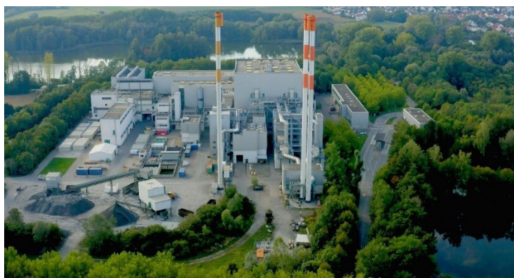
Luftbild Zweckverband Müllverwertungsanlage Ingolstadt
